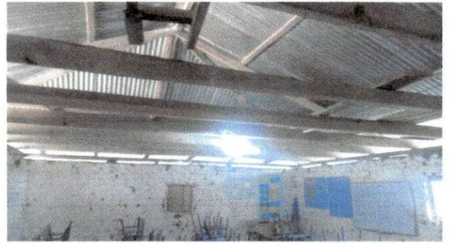
Foto 2: Estructura de techo
