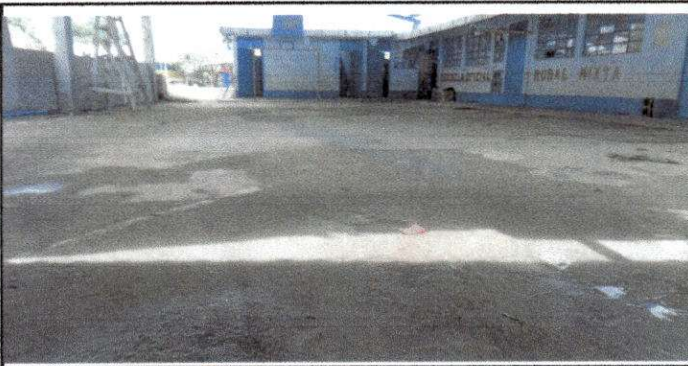
Foto 5: Piso de torta de concreto.
